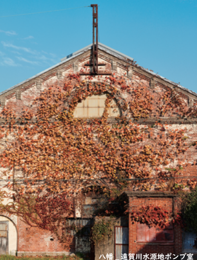
八幡 遠賀川水源ポンプ室
