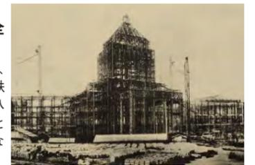
1920(大正9)年に着工され、17年の歳月をかけて完成。鉄骨構造の設計施工は官営八幡製鐵所の景山齊が責任者となり、9,800tにのぼる膨大な鋼材を供給しました。
